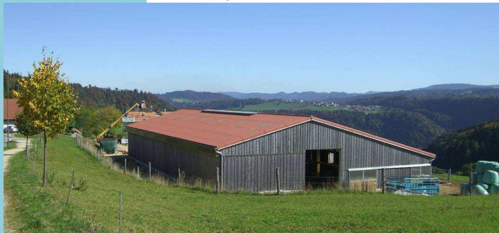
Figure 19: Saint-Brais, volume simple, orientation du faîte dans le sens des courbes de niveaux et parallèle à la route, façades en bois, toiture en éternit, plaques translucides régulières en toiture, faîte vitré aéré, avant-toits réduits au minimum
